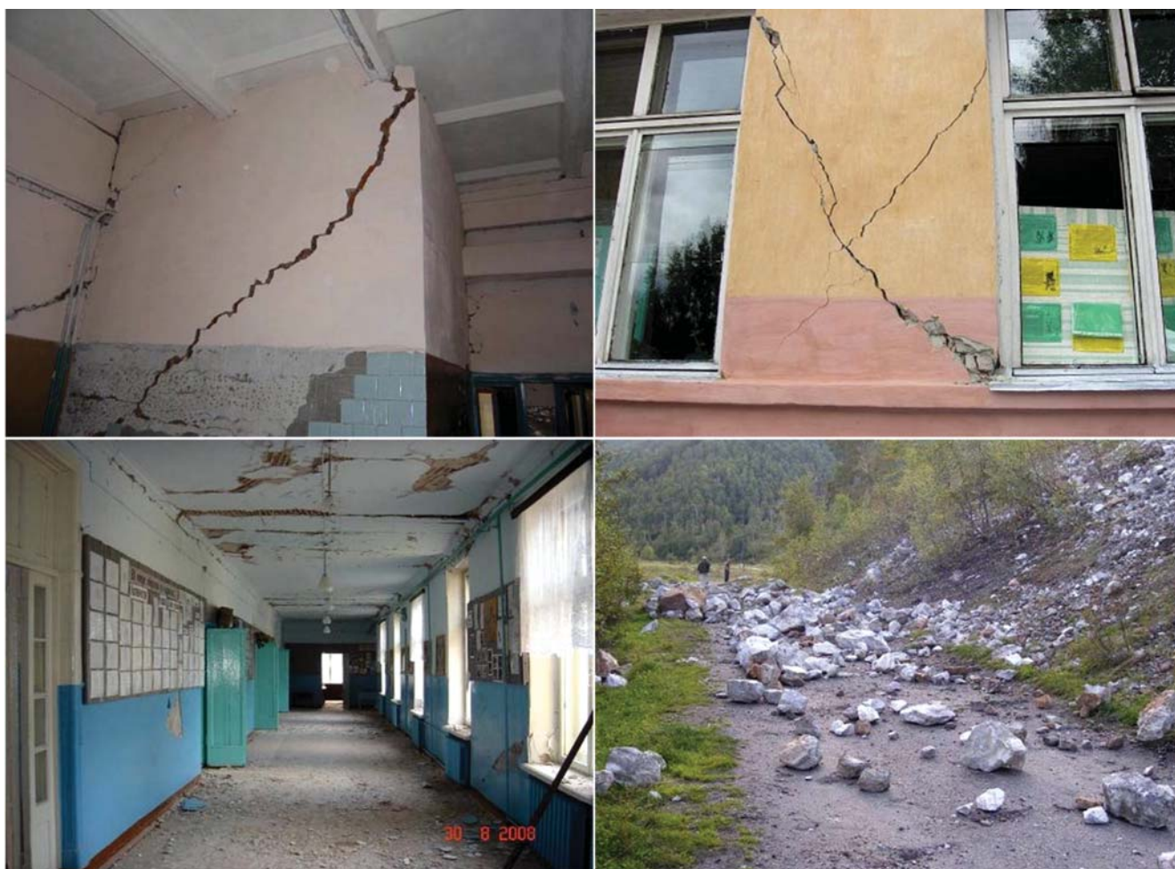
Рис. 1. Последствия 8-балльного (по шкале MSK-64) землетрясения на юге Байкала 27.08.2008 в г. Слюдянке и пос. Култук. Фото с сайта Байкальского филиала Геофизической службы СО РАН ( http://www.seis-bykl.ru )
