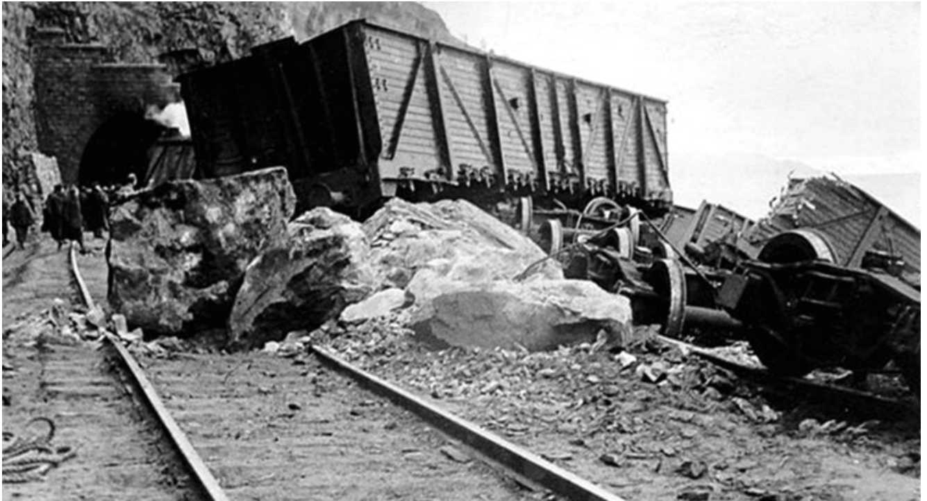
Рис. 3. Последствия обвала в мае 1941 г. у восточного портала тоннеля № 5 (87-й км КБЖД) ( http://www.transsib.ru )
